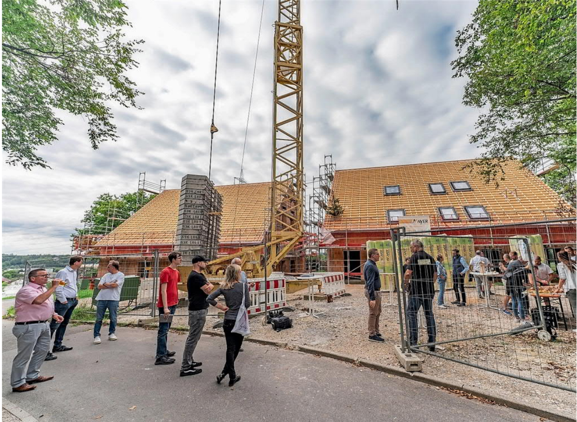
RICHTFEST IN DER STRASSE BREITER WEG IN DER BRAIKE. FOTO: RALF JUST
